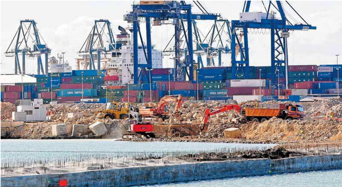
Obras del nuevo muelle de cruceros del puerto de Valencia. DAMIAN TORRES
