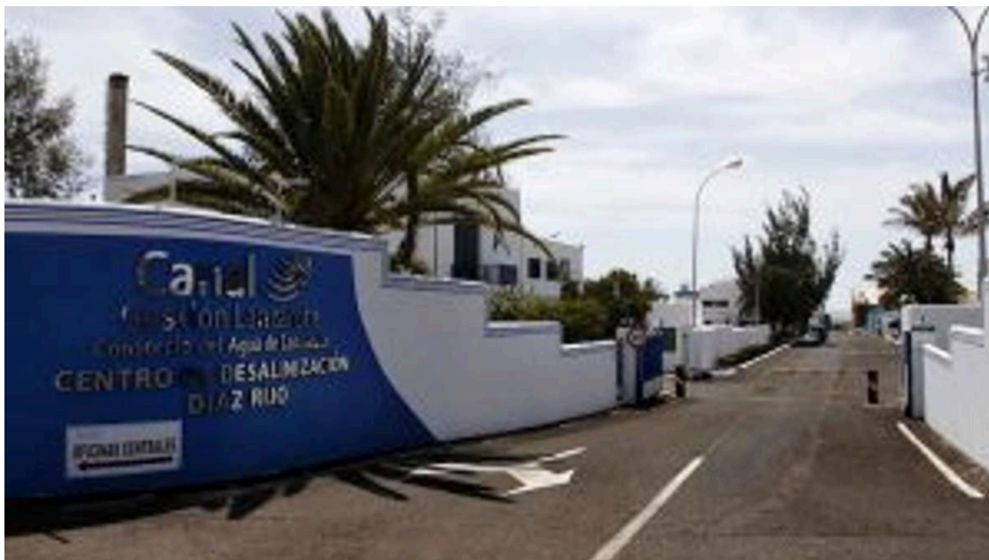
Central de Desalación Díaz Rijo, en Arrecife, donde tiene su sede Canal Gestión Lanzarote. / La Provincia
